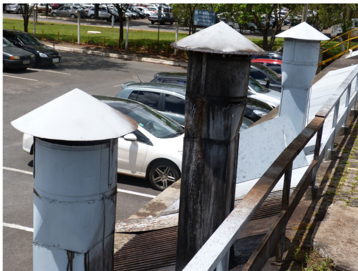
Figura 27 - Conjunto ventilador-chaminé do SVLE da cozinha Fonte: arquivo pessoal
