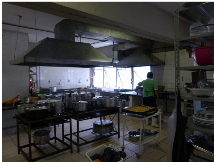
Figura 23 - Visão geral dos exaustores tipo coifa sobre o fogão industrial e grelha elétrica Fonte: arquivo pessoal
