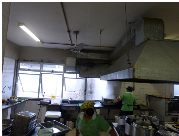
Figura 25 - Detalhe da tubulação do SVLE dos fogões Fonte: arquivo pessoal
