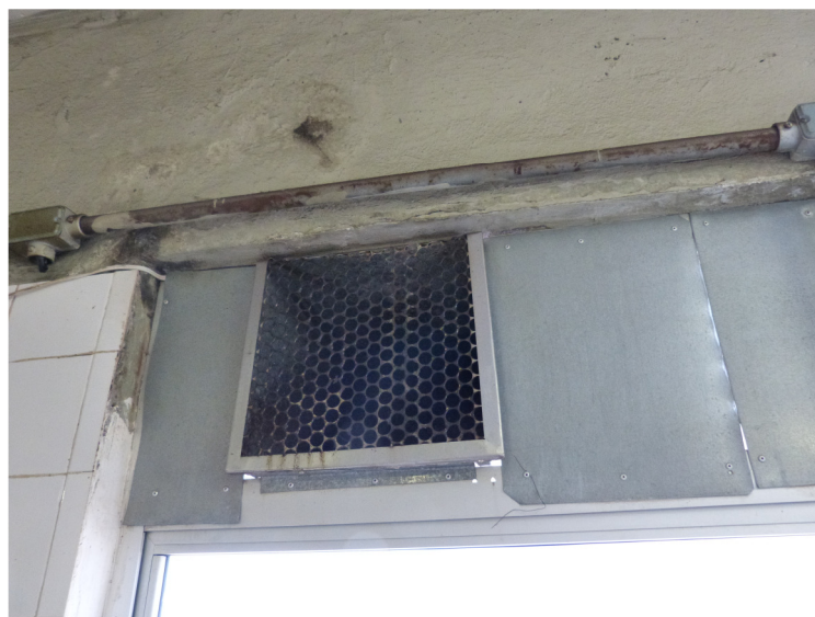
Figura 24 - Detalhe do captor tipo lateral sobre o forno a gás Fonte: arquivo pessoal
