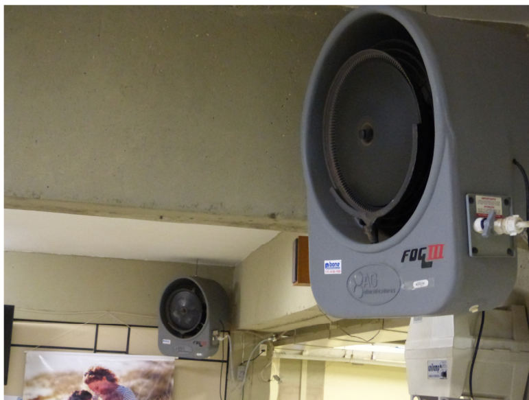
Figura 19 – Umidificadores instalados no saguão principal do subsolo onde fica o restaurante Fonte: arquivo pessoal
